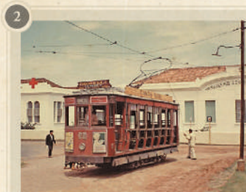
Bonde 3 no terminal da Santa Casa de Misericórdia (edificações ao fundo). Observe o cobrador realizando a inversão do coletor de eletricidade para que o bonde retorne pelo mesmo trajeto. Isso ocorria também em outros pontos finais, como: Diocesano, Estação (linha marrom) e Mercado Municipal. Nesses casos, o motoneiro mudava de cabine.
